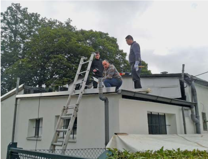
Sanierungsarbeiten im KGV Mutterkamp: Lutz, Dieter und Long nehmen Ausbesserungsarbeiten am Dach des Vereinsheims vor.
